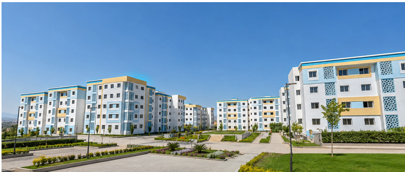
Les Lauriers TR2 — 280 apartments, Charafate, Tanger · Al Omrane · 371M MAD
